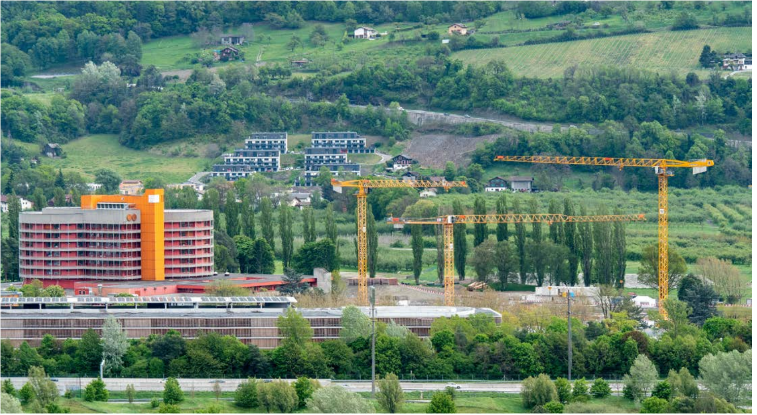
Ansicht des Spitals Sitten, des Parkhauses und der Baustelle des Ausbaus vom Nordhang der Stadt aus.
